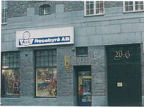
17. Lådskylden förtar fasadens karaktär. Bättre med friliggande bokstäver.
